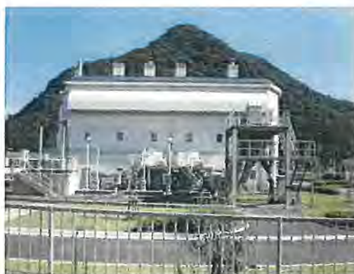
ポンプ施設の例（駅前雨水ポンプ場：上郡町）
