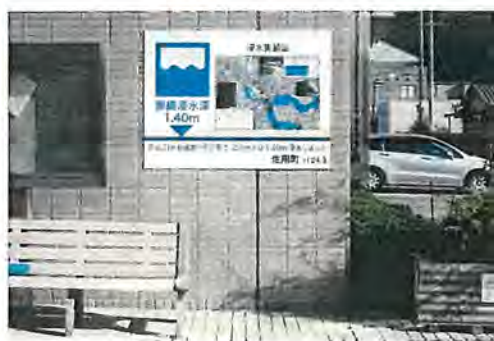
実績浸水深表示板 H21 災害・佐用町上月庁舎
