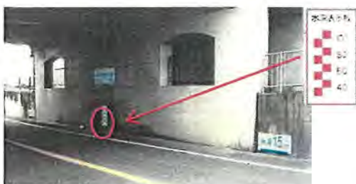
道路アンダーパスの水深表示板
