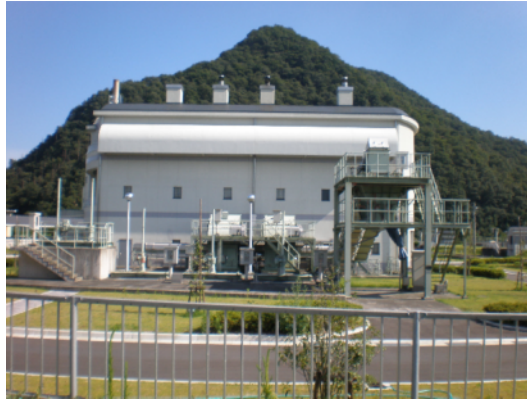
図 12 ポンプ施設の例（駅前雨水ポンプ場:上郡町）
