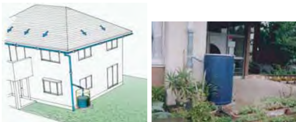
図 10 各戸貯留施設の例(地上タイプ)
