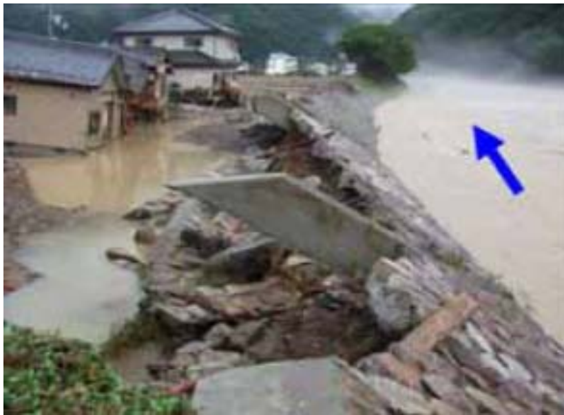
图 17 佐用川左岸(久崎地区)
