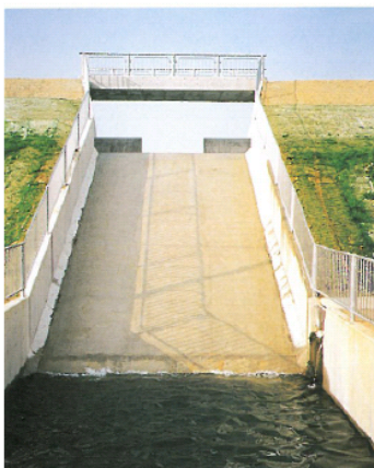
「洪水吐完成写真」
