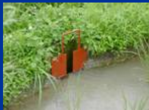
せき板の設置
