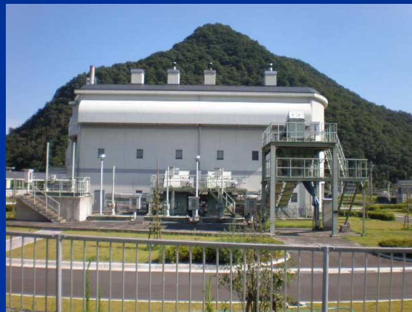
駅前雨水ポンプ場 (上郡町)
