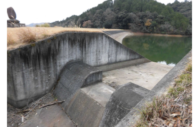
写真③ 洪水吐を改良したため池 の事例(相生市 瓜生大池)
