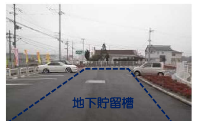
写真⑥ 指定雨水貯留施設の事例 (宍粟市内民間店舗)
