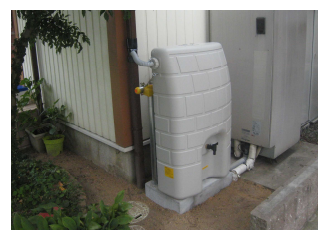
写真⑤ 各戸貯留施設の事例 (たつの市)
