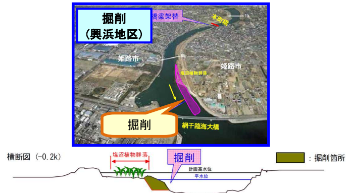
掘削による対策の一例
