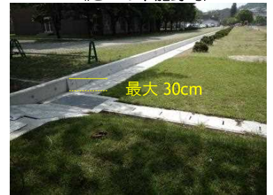
写真② 兵庫県立大学姫路環境人間 キャンパスの校庭貯留の事例
