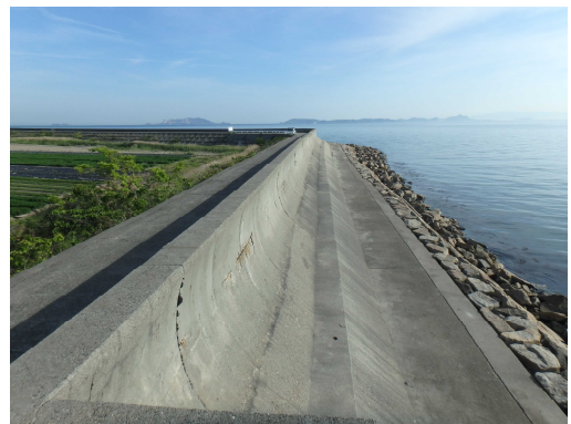
老朽化対策 (御津海岸 成山新田地区)
