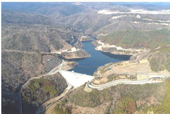
治水対策 (金出地ダム) H30.3 完成
