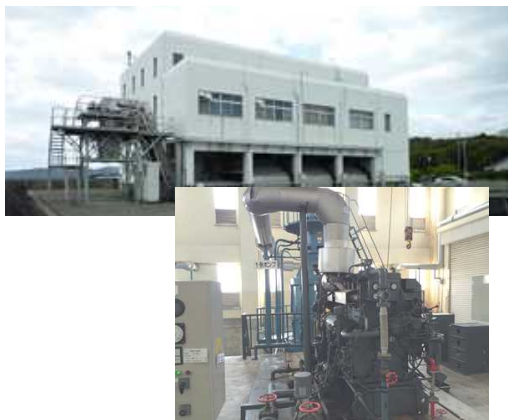
老朽化対策 ( (二) 加里屋川 排水機場)
