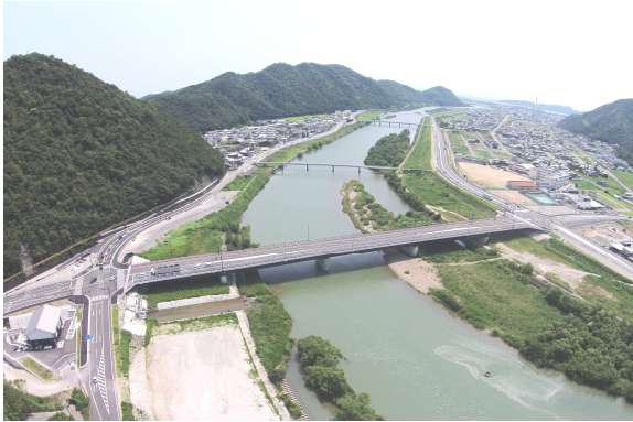
(国) 250号(坂越道路) H28.3 供用
