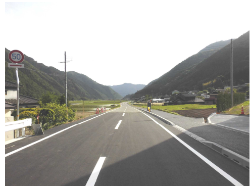
(主) 加美宍粟線(能倉バイパスⅠ) H30.5 供用
