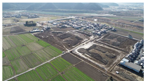
ほ場整備 (岩見構下地区) 事業実施中
