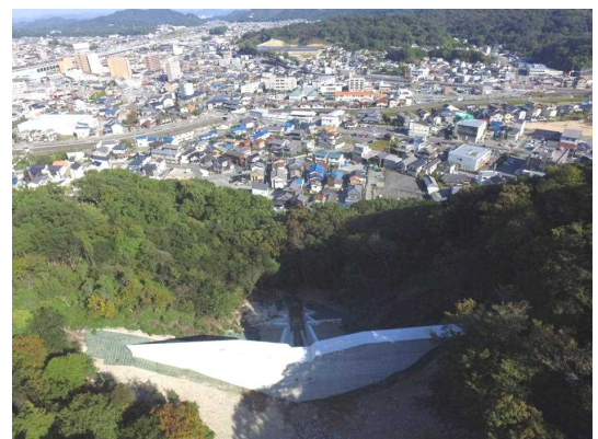
砂防事業 (那波本町川) H29.7 完成
