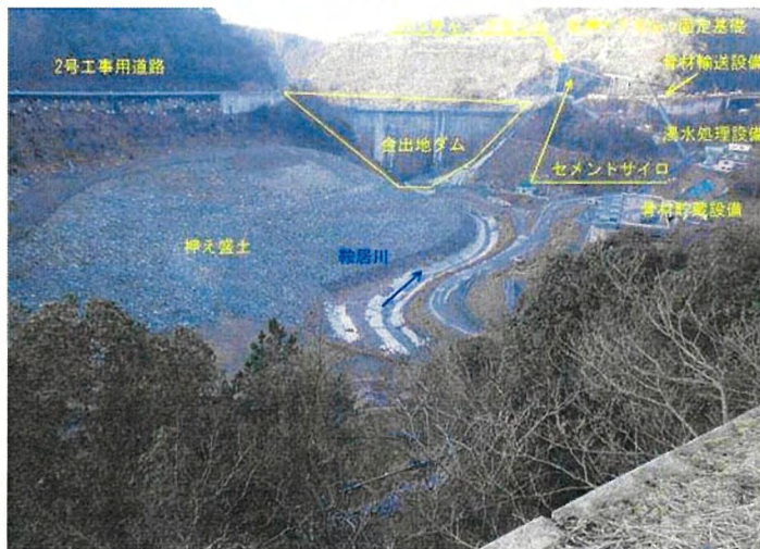
上流から金出地ダムをのぞむ (H27.1)
