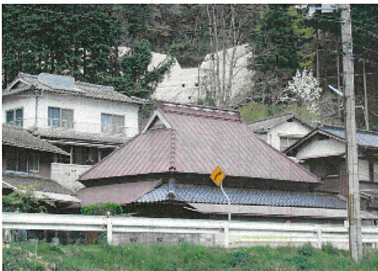
砂防えん堤(佐用町下石井 東谷川)
