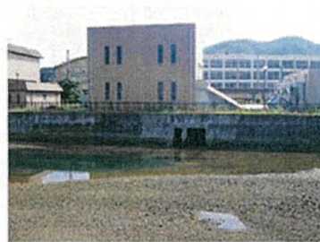
佐方雨水ポンプ場 最大放流量 2.612m 3 /s
