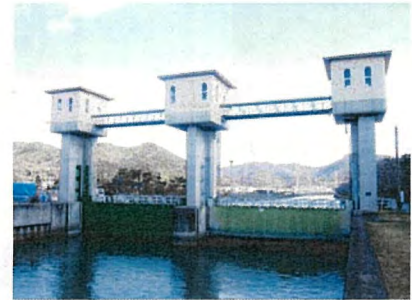
塩屋川防潮水門 (30年経過)
