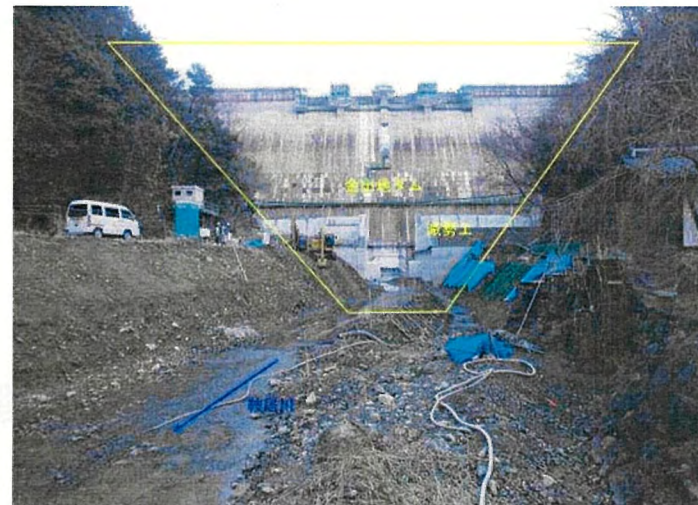
下流から金出地ダムをのぞむ (H27.1)
