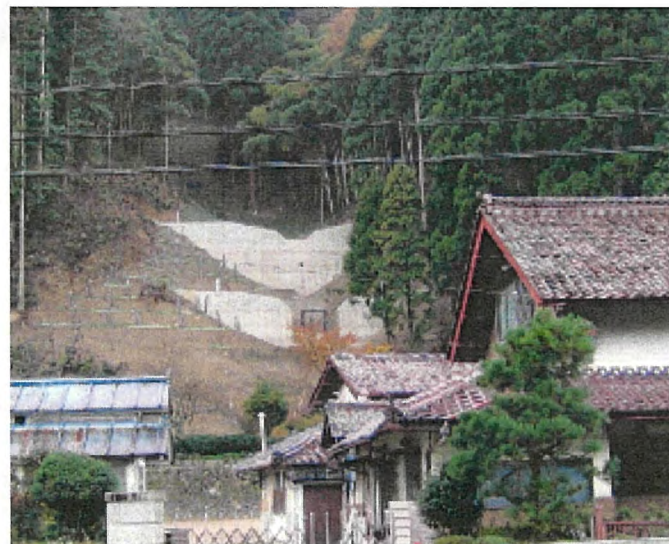
治山ダム(朝来市 八代)
