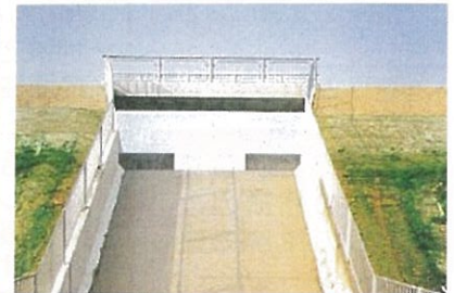
写真③ 洪水吐を改良したため池の事例
