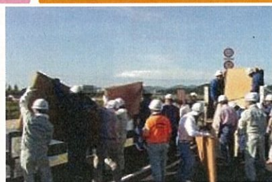
写真④ 畳堤での水防訓練(たつの市)
