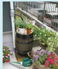
個人宅に設置された雨水タンク
