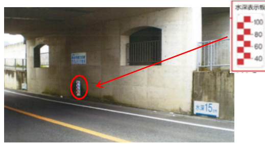
図 19 道路アンダーパスの水深表示板（竹万アンダーパス）
