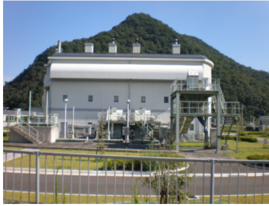
図 12 ポンプ施設の例（駅前雨水ポンプ場:上郡町）
