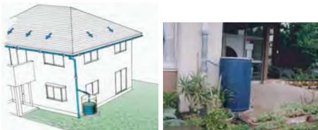
図 10 各戸貯留施設の例(地上タイプ)
