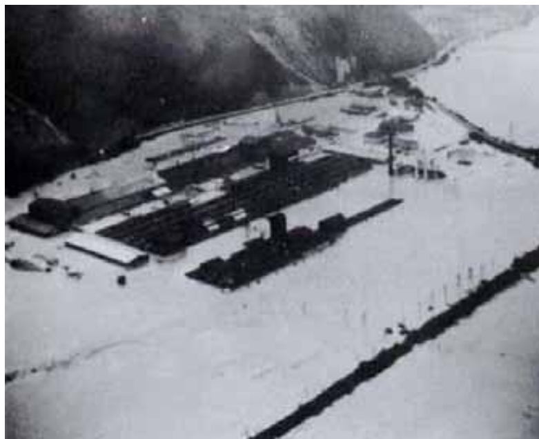
出典：昭和 51 年台風 17 号災害誌，兵庫県 図 7 千種川（ユニチカ化成坂越工場）S51.9
