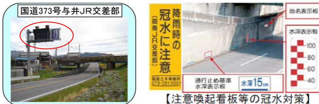
図 44 アンダーパス冠水情報板などの設置状況
