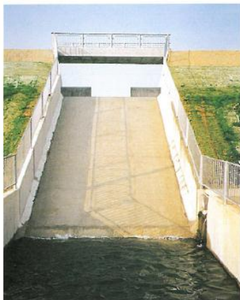
「洪水吐完成写真」
