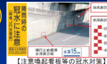
道路冠水対策
