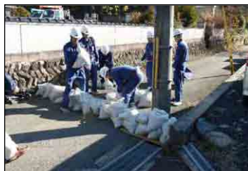
土嚢積み（宍粟市）
