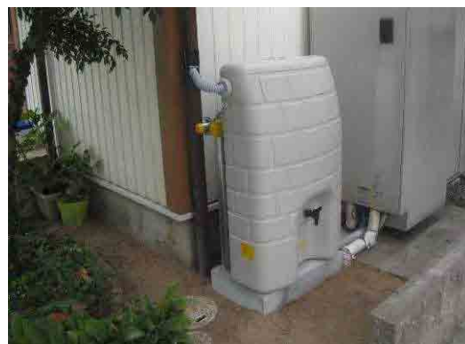
図 5-11 各戸貯留施設の例(地上タイプ)
