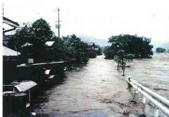
宍粟橋右岸浸水状況(宍粟市山崎町)
