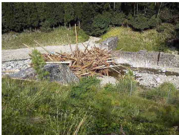
写真 5-5 土砂・流木の捕捉状況(谷川砂防えん堤)平成 21 年 8 月
