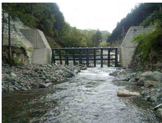
写真 5-6 砂防えん堤(福知川)
