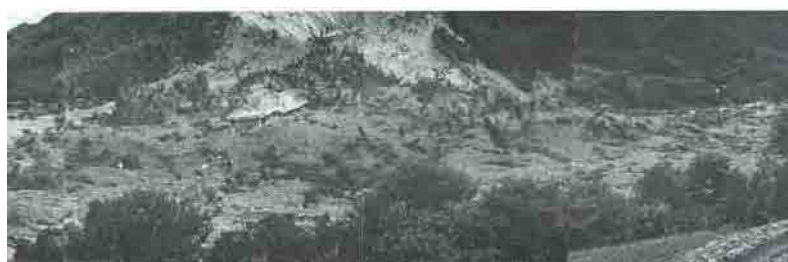
山崩れによる揖保川の堰止状況(宍粟市一宮町福知付近)
