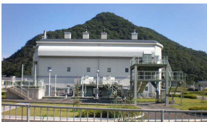
駅前雨水ポンプ場 (上郡町)
