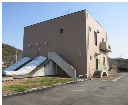
佐方ポンプ場
