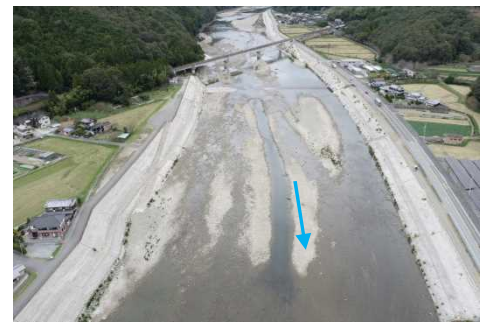
千種川・河野原地区（上郡町） 【滯筋試験施工時】
