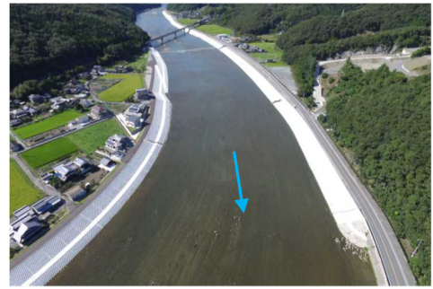
千種川・河野原地区（上郡町） 【復緊急事業完成時】
