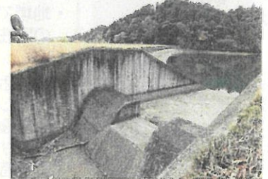
写真③ 洪水吐を改良したため池の事例(相生市 瓜生大池)
