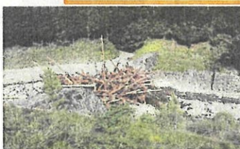
写真⑧ 土砂・立木の捕捉状況 (宍粟市 谷川砂防えん堤)
