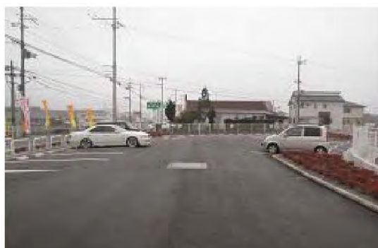
図 5-3 設置した指定雨水貯留施設
