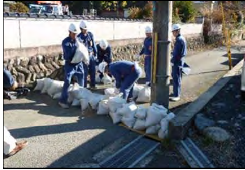
宍粟市 土嚢積み
