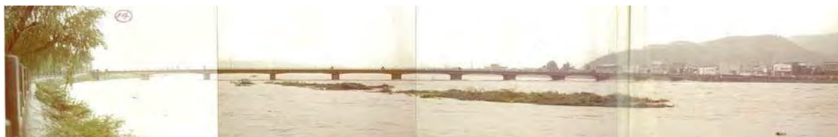
洪水中の龍野橋の状況(たつの市)
