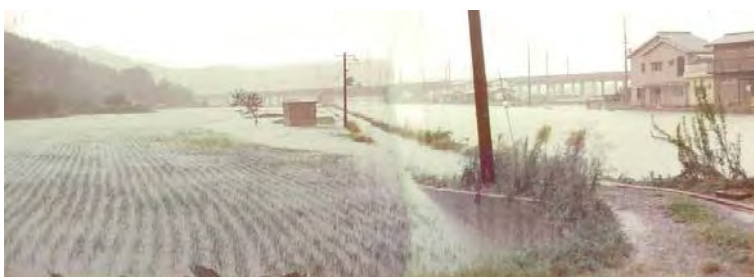
馬路川内水被害の状況(たつの市揖保川町)
