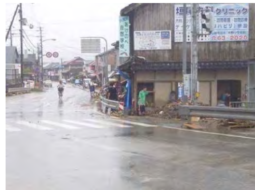
安積橋下流浸水状況(宍粟市一宮町)
