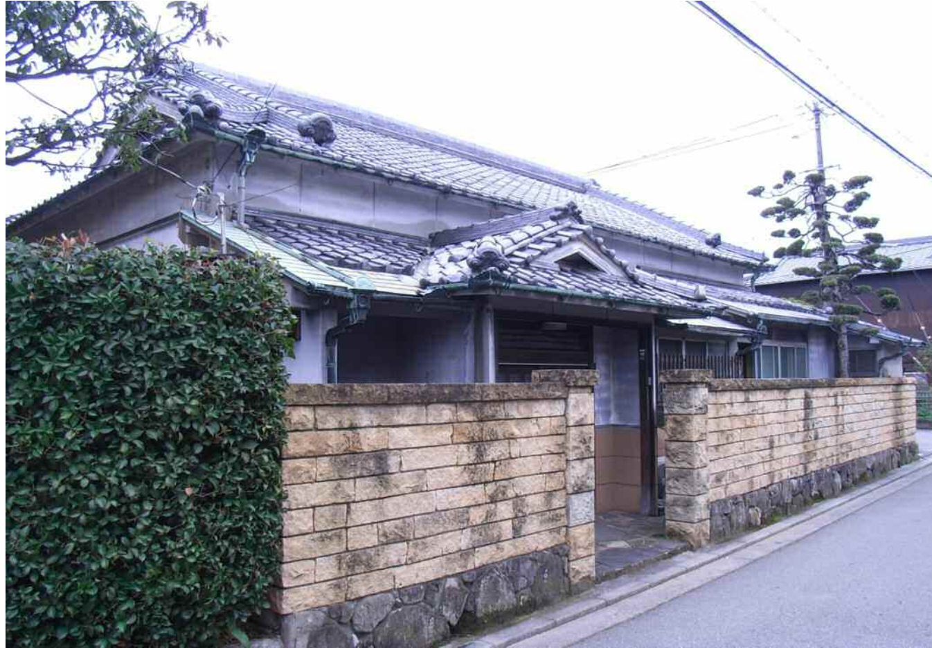
北側道路よりの外観（改修前） 主屋は背の高い石積みの塀に囲まれ、玄関の屋根は増築されていた
