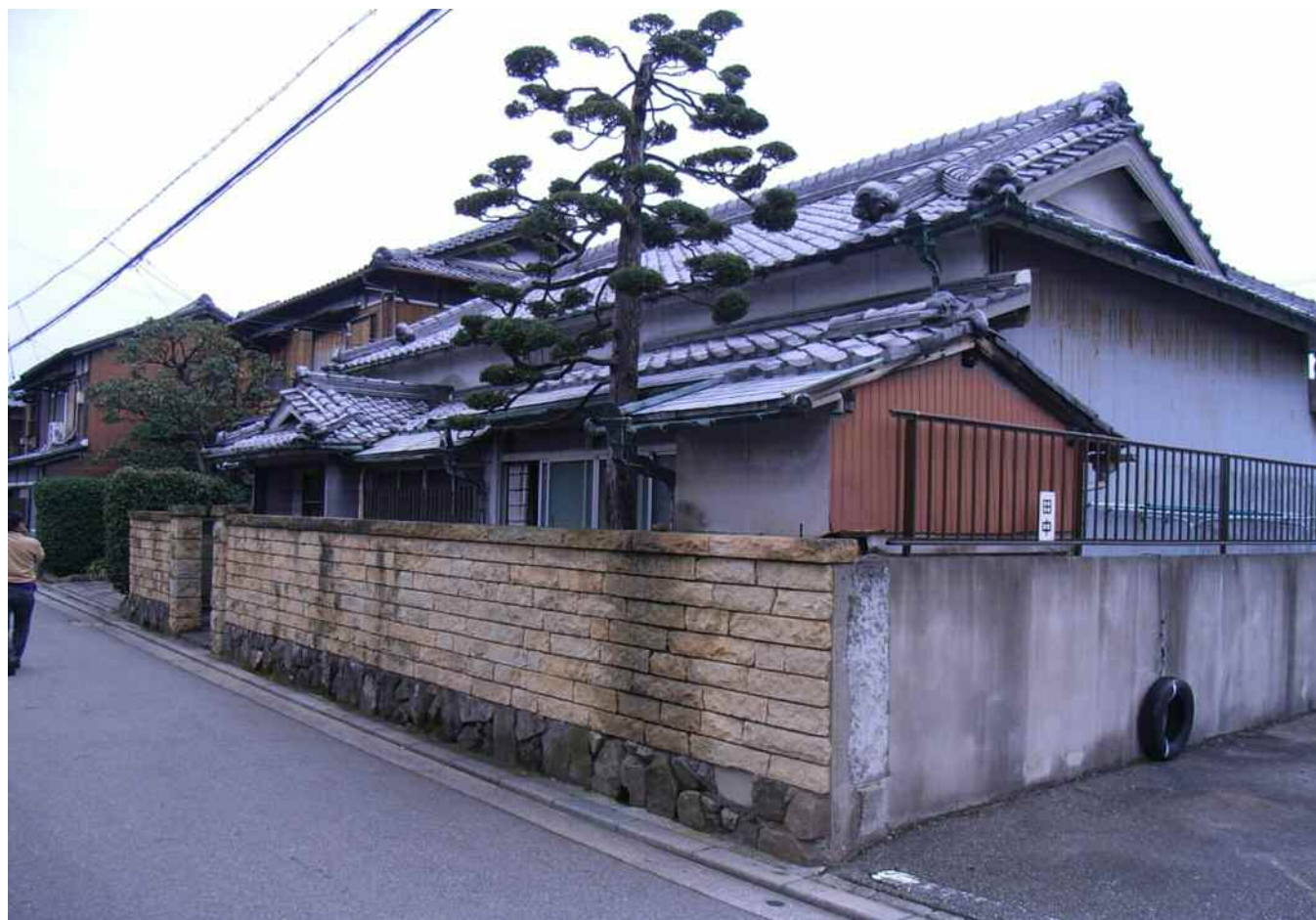
北側道路西側よりの外観（改修前）
