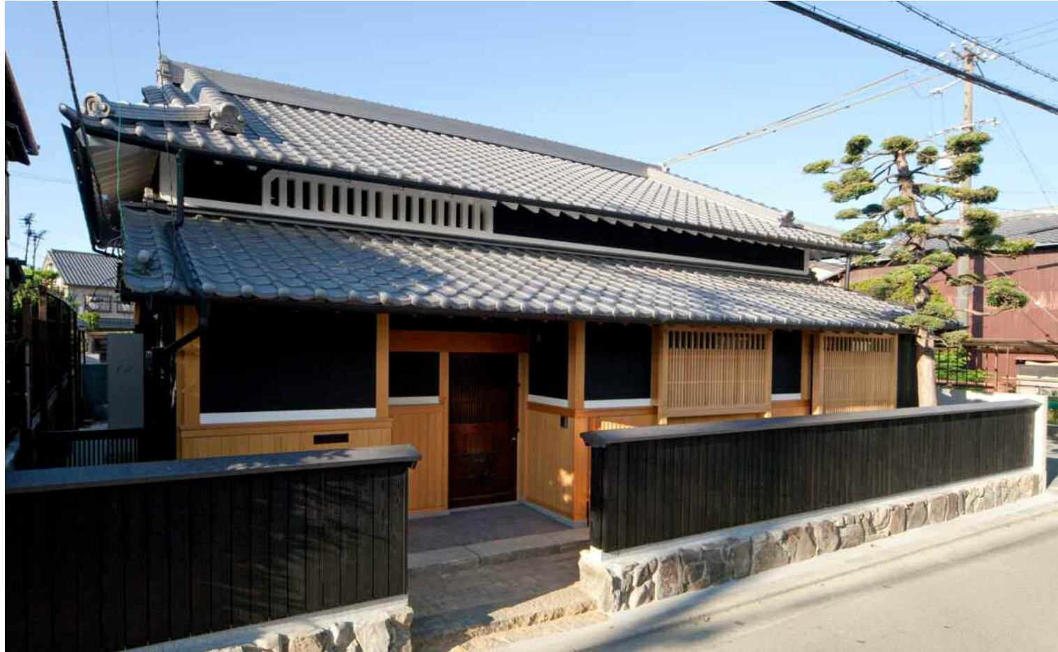
北側道路よりの外観（改修後） 石積みの塀を道路後退のセットバックし低い板塀に変更 玄関の屋根は平入りの形に戻し、塞がれていた虫籠窓を再現
