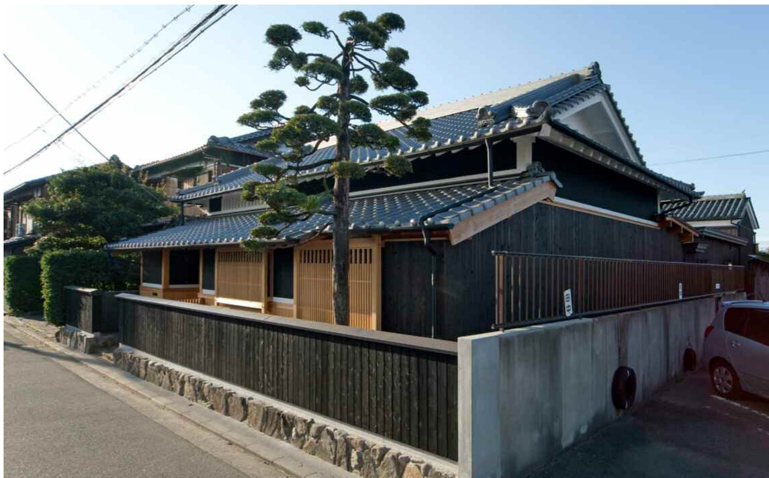
北側道路西面よりの外観（改修後） 手前より母屋・増築部分・蔵とつながる。母屋の屋根は瓦を新しくし、蔵の屋根は既存の瓦を葺きなおした。
