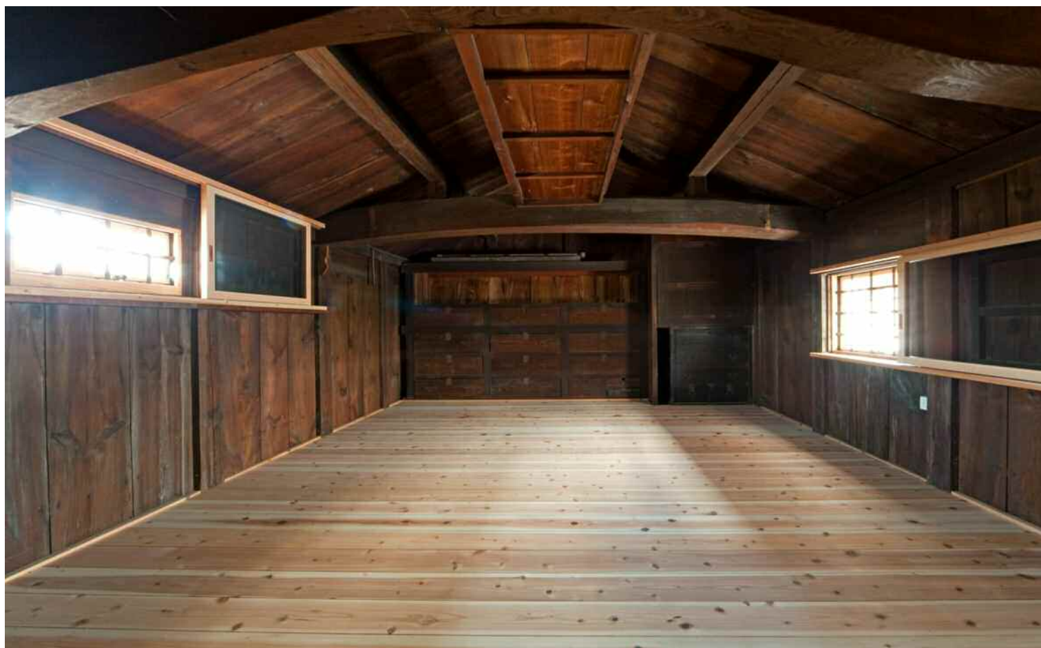
蔵内部：2階（改修後）
