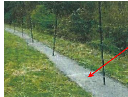
電気柵設置場所への鉄鋼スラグ材敷設例
