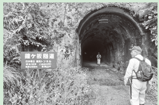
鐘ヶ坂トンネル(明治のトンネル)
