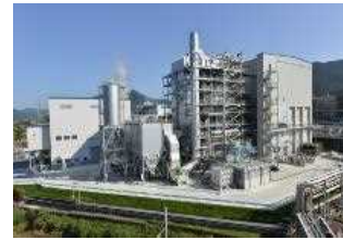
木質バイオマス発電施設(丹波市)
