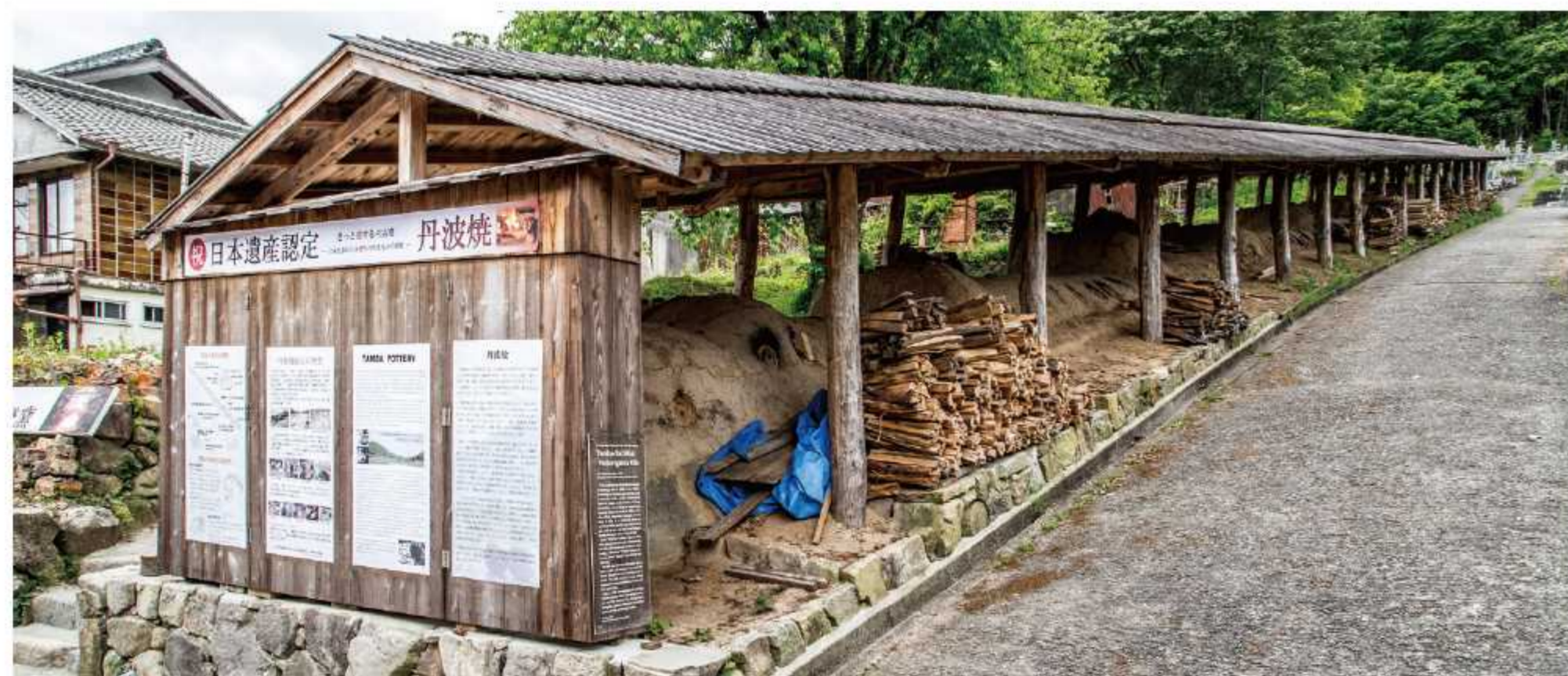
現存する最古の登窯は明治28年に造られました。長さは47メートルもあります。
