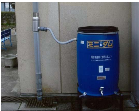
その他の雨水貯留・浸透の取り組み（左：雨水貯留タンク、右：浸透管・浸透枳）
