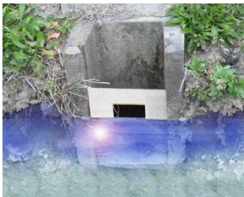
水田貯留の例（兵庫県千種川流域「田んぼダム」） ちくさがわ
