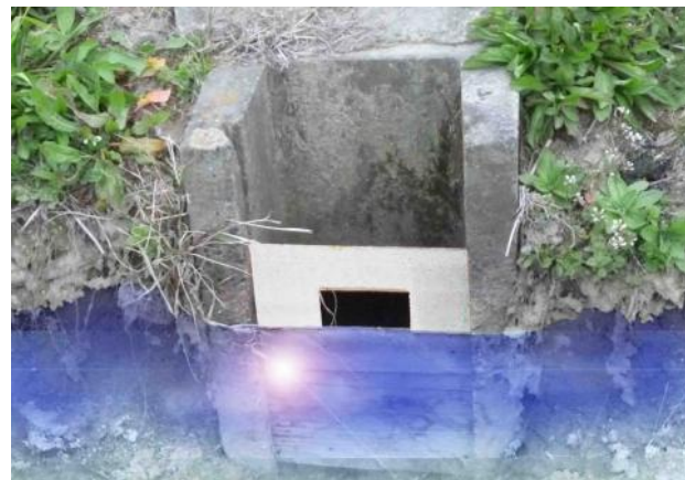
調整板設置イメージ図
