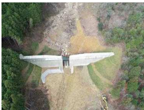
堀壁川（丹波市）
