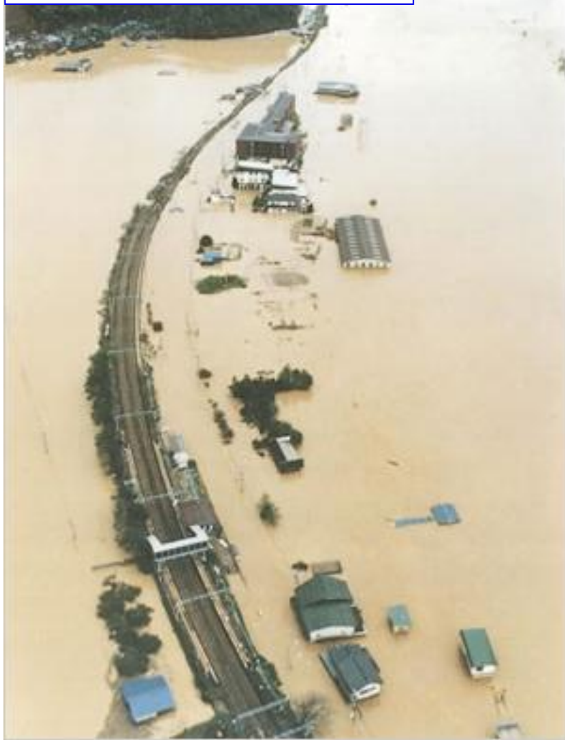
円山川の氾濫により冠水した JR山陰本線玄武洞駅付近
