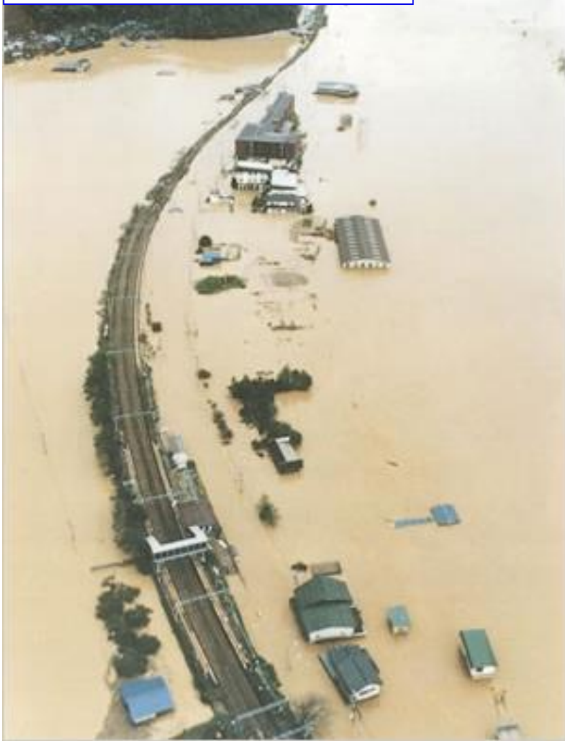
円山川の氾濫により冠水した JR山陰本線玄武洞駅付近
