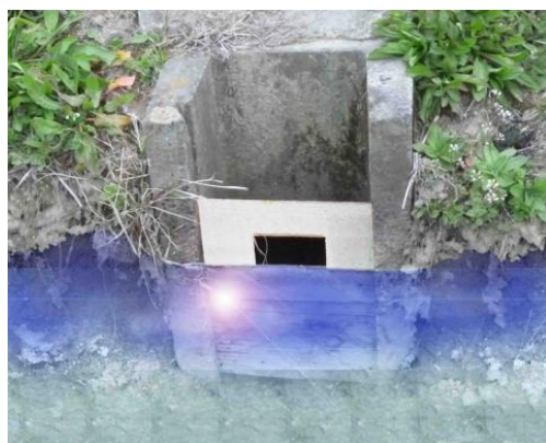
水田貯留の例（兵庫県 ちくさがわ 千種川流域「田んぼダム」）
