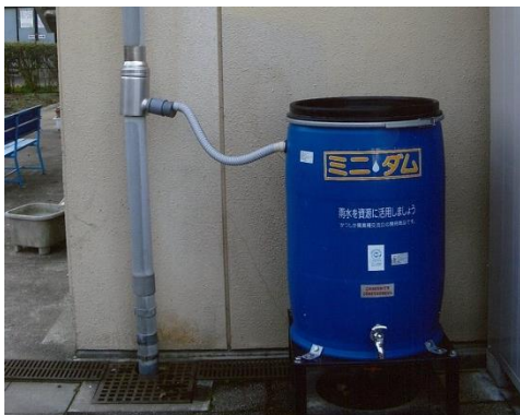
その他の雨水貯留・浸透の取り組み（左：雨水貯留タンク、右：浸透管・浸透枳）
