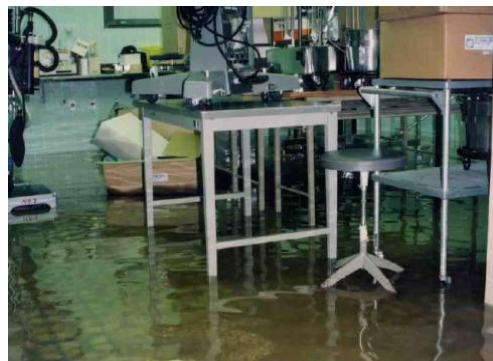
平成2年9月洪水による浸水状況 (公立香住病院)
