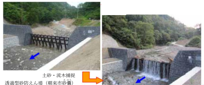
砂防えん堤による土砂の捕捉状況（神子畑川：朝来市）
