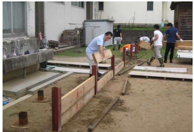
香住第一中学校における 校庭貯留施設の設置状況
