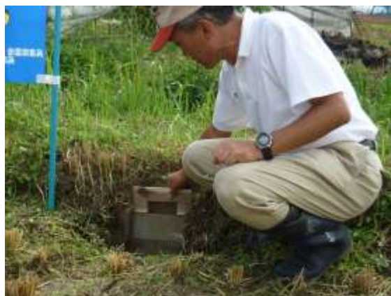
【せき板を設置する様子】
