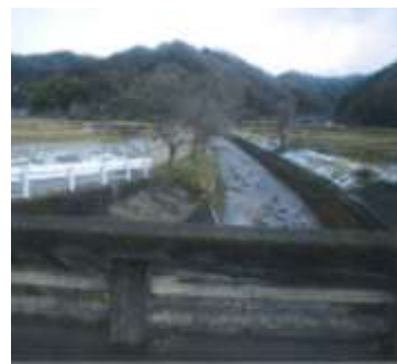
堆積土砂撤去後（日高町）
