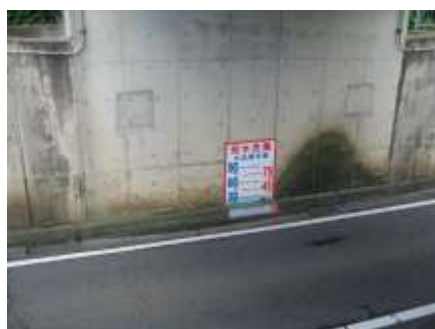
市道アンダーパス部の水位表示板
