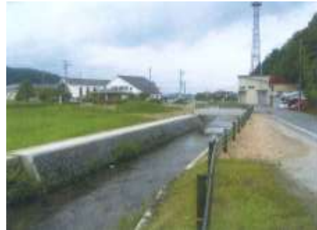
整備後（出石町内）
