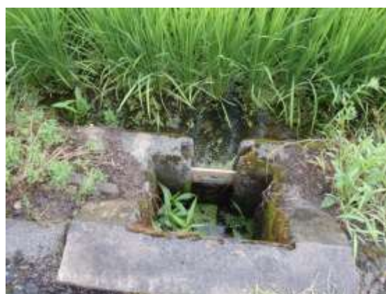
【せき板の設置状況】
