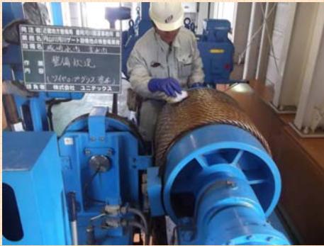
城崎水門での点検状況
