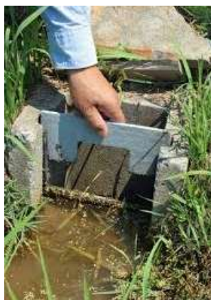
せき板による水位調整
