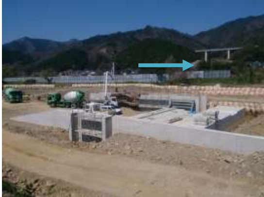
【朝来市物部 井堰改築工事】
