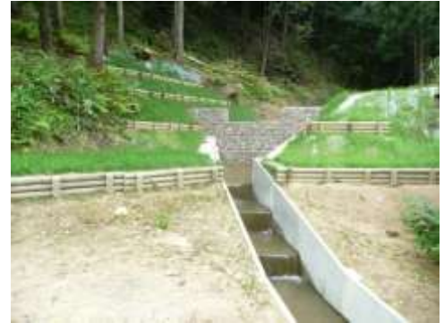
【豊岡市但東町大河内 緊急防災林の整備（間伐木土留工）】 【豊岡市出石町奥山 里山防災林の整備（床固工）】
