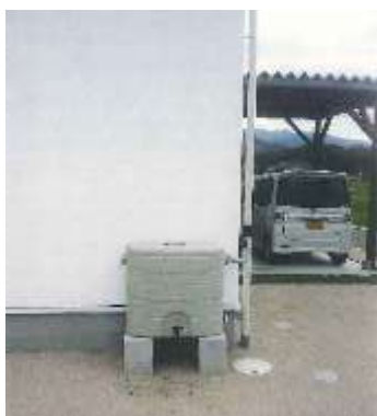
家庭用雨水貯留タンク設置
