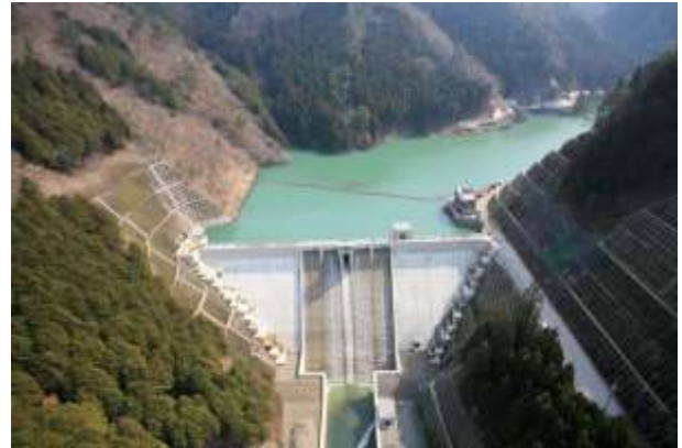
【H26年6月に完成した与布土ダム】
