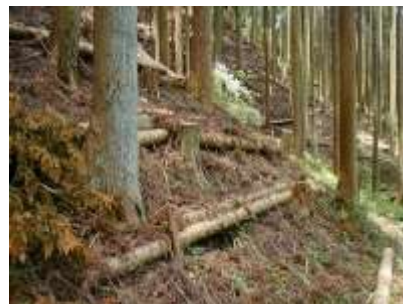
緊急防災林整備 (間伐木を利用した土留工の設置)
