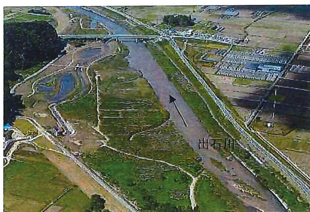
加陽地区大規模湿地再生（平成 25 年 10 月撮影）
