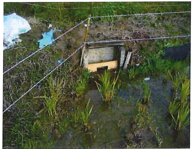
せき板の設置状況(新温泉町二日市)
