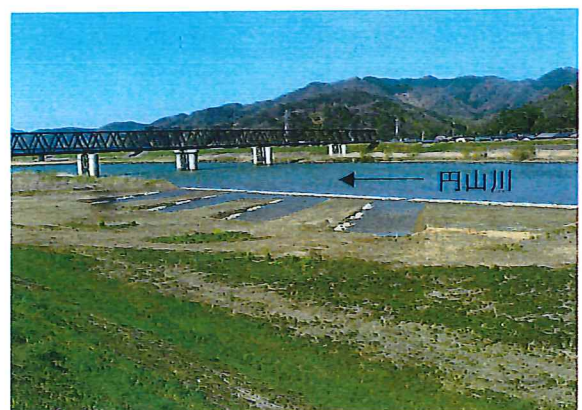
本川中流地区湿地再生（平成 27 年 4 月撮影）
