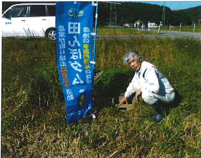
せき板を設置する様子(豊岡市日高町山本)
