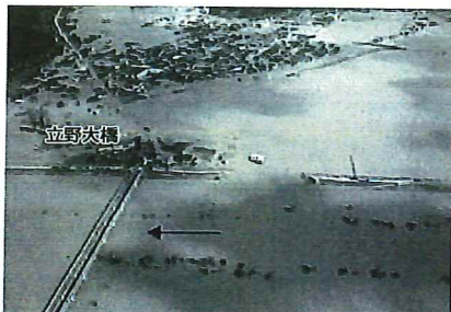
円山川決壊地点の状況
