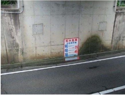
市道アンダーパス部の水位表示板
