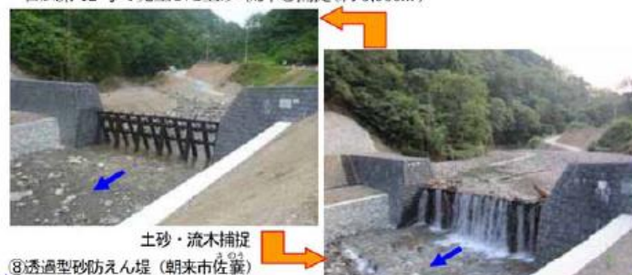
朝来市の神子畑川における砂防堰堤による土砂の捕捉状況（2011（平成 23）年台風 12 号）
