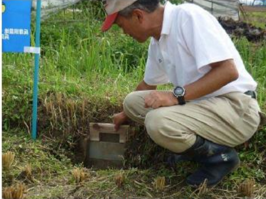
せき板を設置する様子
