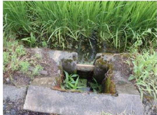
せき板の設置状況
