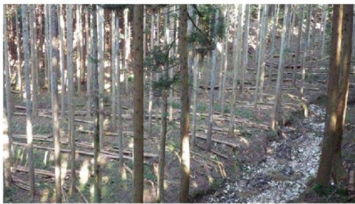
豊岡市但東町大河内 緊急防災林の整備（間伐木土留工）
