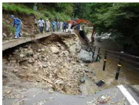
護岸崩壊による道路崩落箇所
