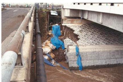
香住町（当時）油良の油良橋護岸の被災状況
