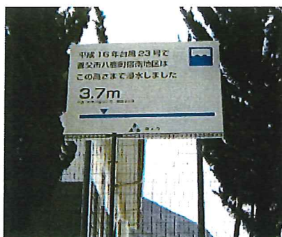
宿南浄化センター
