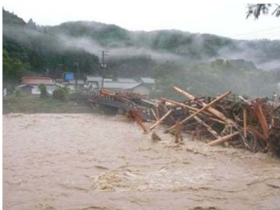
図 5.6.4 朝来市の神子畑川における流木による橋梁部の閉塞状況（2009（平成 21）年 8 月豪雨時）
