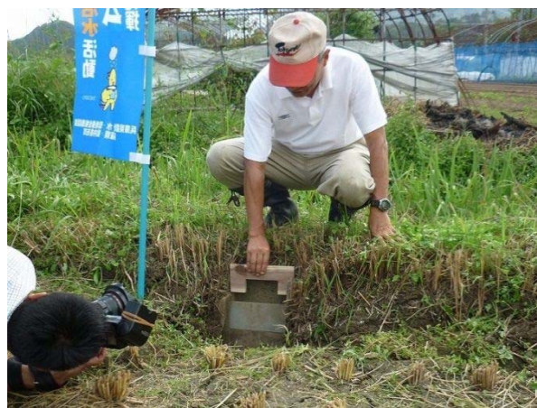
図 5.2.6 せき板を設置する様子（朝来市和田山町林垣）
