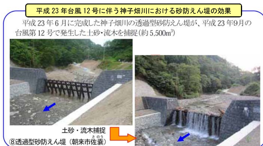
図 5.6.6 朝来市の神子畑川における砂防堰堤による土砂の捕捉状況（2011（平成23）年9月豪雨時）
