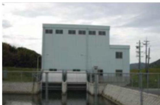
図 5.4.1 一日市排水機場（豊岡市、2001（平成13）年完成） （国土交通省 ホームページ「円山川流域委員会資料」より）
