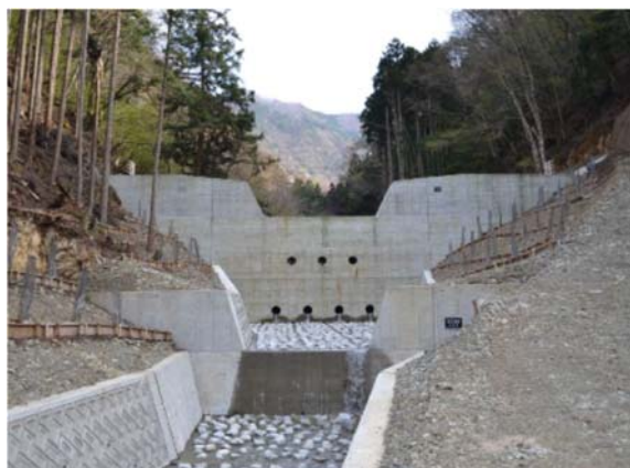
図 5.6.5 治山ダムの例（朝来市 きのう 佐囊）
