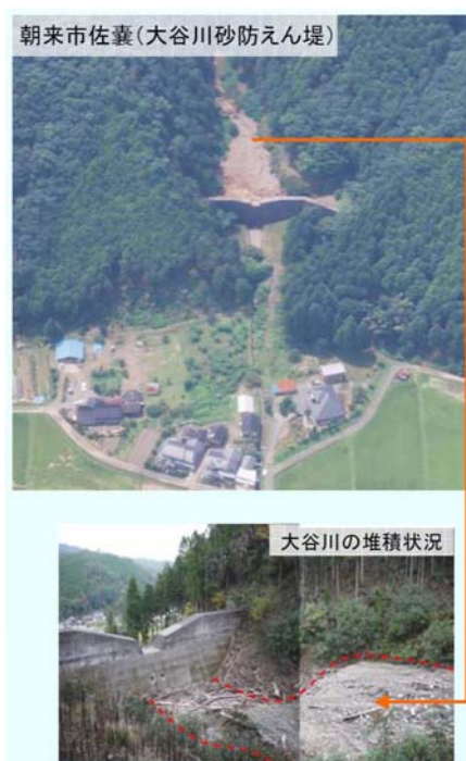
図 5.6.7 朝来市の大谷川砂防堰堤による土砂の捕捉状況（2009（平成21）年8月豪雨時）
