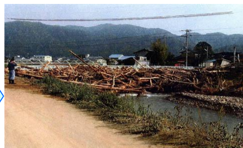
奥山川（出石町鍛福（かふく）橋）の流木による河道閉塞状況（2004（平成16）年台風23号）
