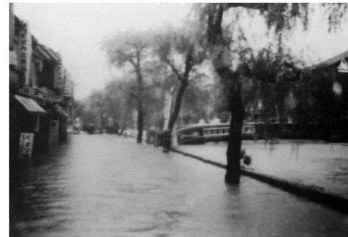
城崎町（当時）の円山川水系大谿川の 氾濫による浸水状況
