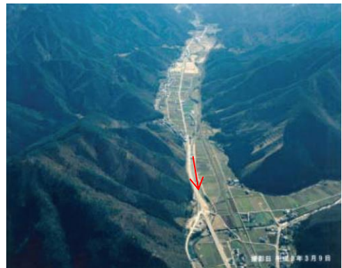
円山川上流部付近（朝来市）
