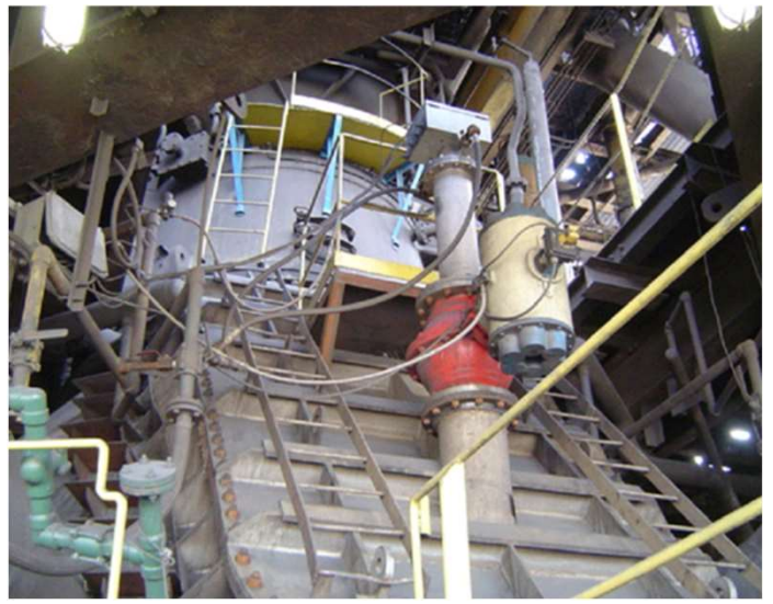
ブラジルCSN社の高炉上のレベル計
