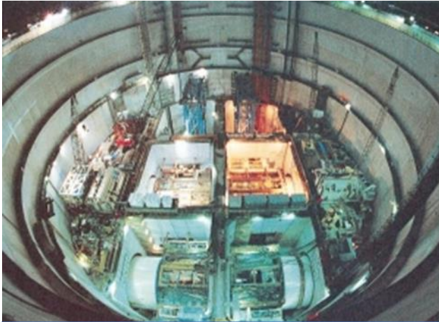
東京湾アクアライン工事・川崎人工島
