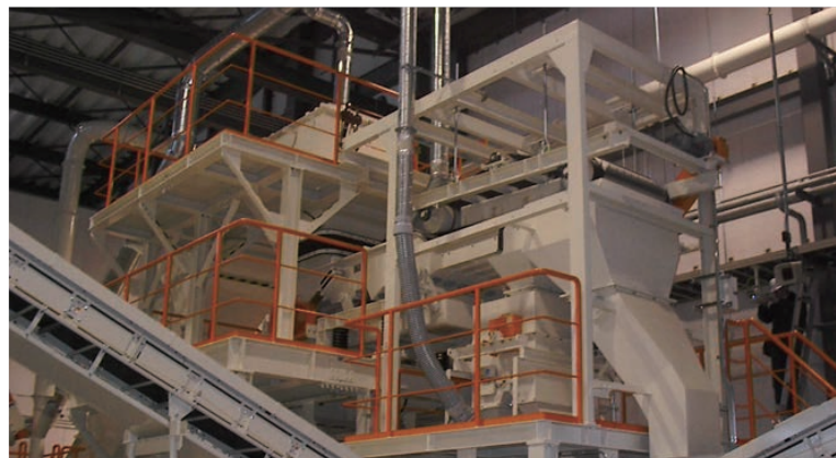
小型家電・基板リサイクルプラント
