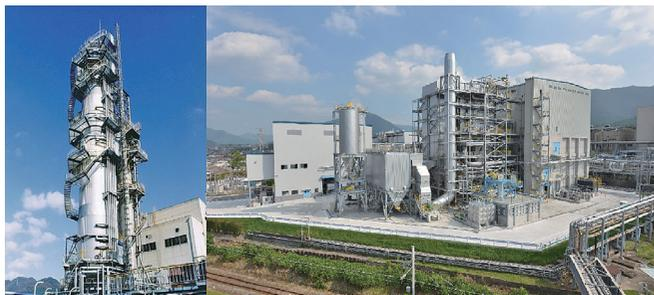
原材料の木材チップを炊く釜(左)、5号バイオマス発電設備(右)です
