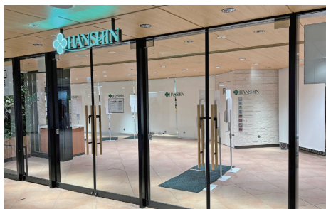
エントランスの強化ガラスドア施工例
