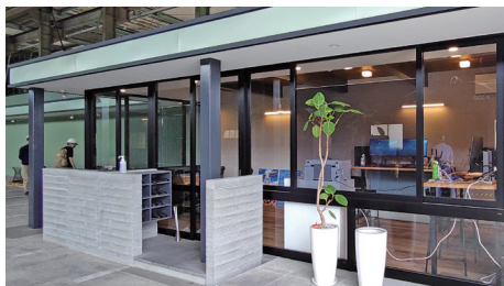
工場建屋内に整備されたユニークなサテライトオフィス
