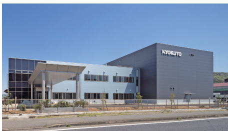
令和4年4月完成 神岡新工場
