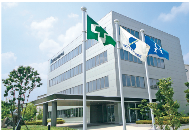
セツカートン(株) 本社および伊丹工場事務所棟
