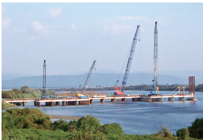
作業用構台架設 (リーブラ工法)
