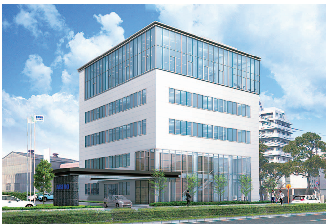
2018年6月竣工 阿比野建設本社事務所
