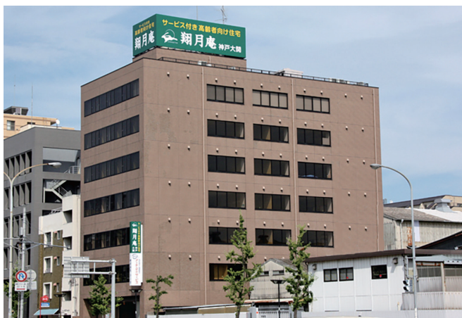
シーナ神戸大開ビル(サービス付高齢者向け住宅・デイサービス)
