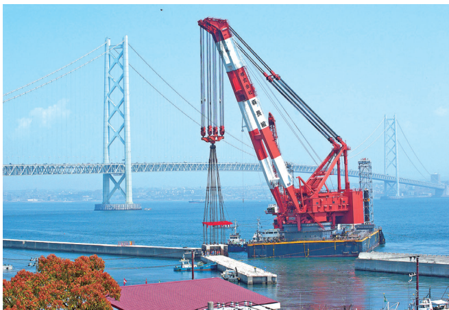
若屋港にて防波堤工事に従事する第一豊号
