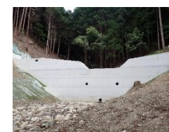
治山ダムの整備
