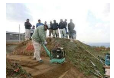
ため池堤体の補修指導
